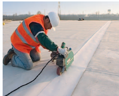
Saldatura giunti/Overlap Welding
